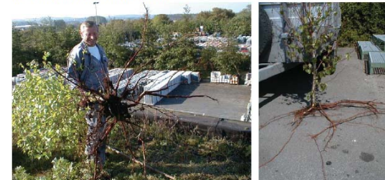
Afb. 51 Verwijdering van een berk op een begroend dak.
