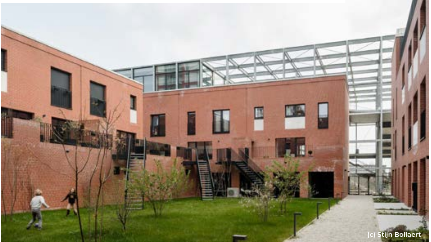
Gemengd Woonproject DEK - Betaalbare woningen in bel-étage (BLAF Architecten / ONIX / eld)
