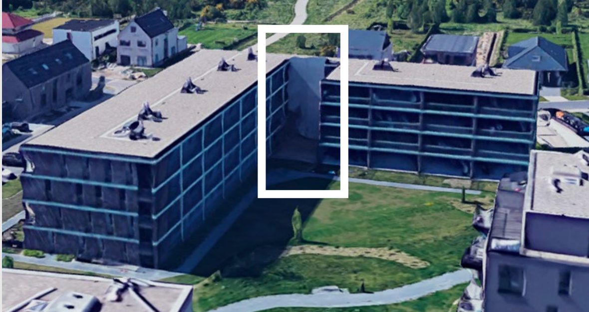
Fig. 10: Het 'inkommetje', een perfecte speelplek door de betonnen muur en harde ondergrond
